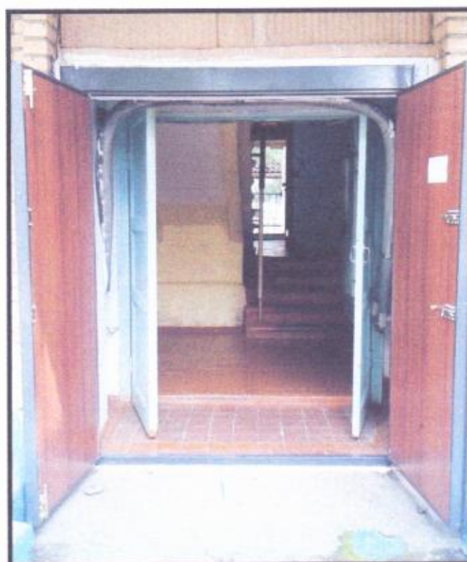
Фото № 5 «Эвакуационный выход»
